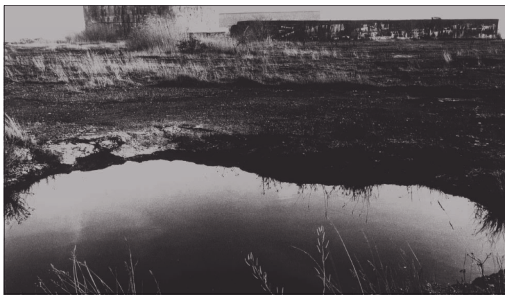
Auf der Halbinsel zwischen Weser und Industriehafen sollte der U-Bootbunker „Hornisse“ entstehen, links daneben der Luftschutzbunker 50, im Vordergrund ein Bombenkrater.
