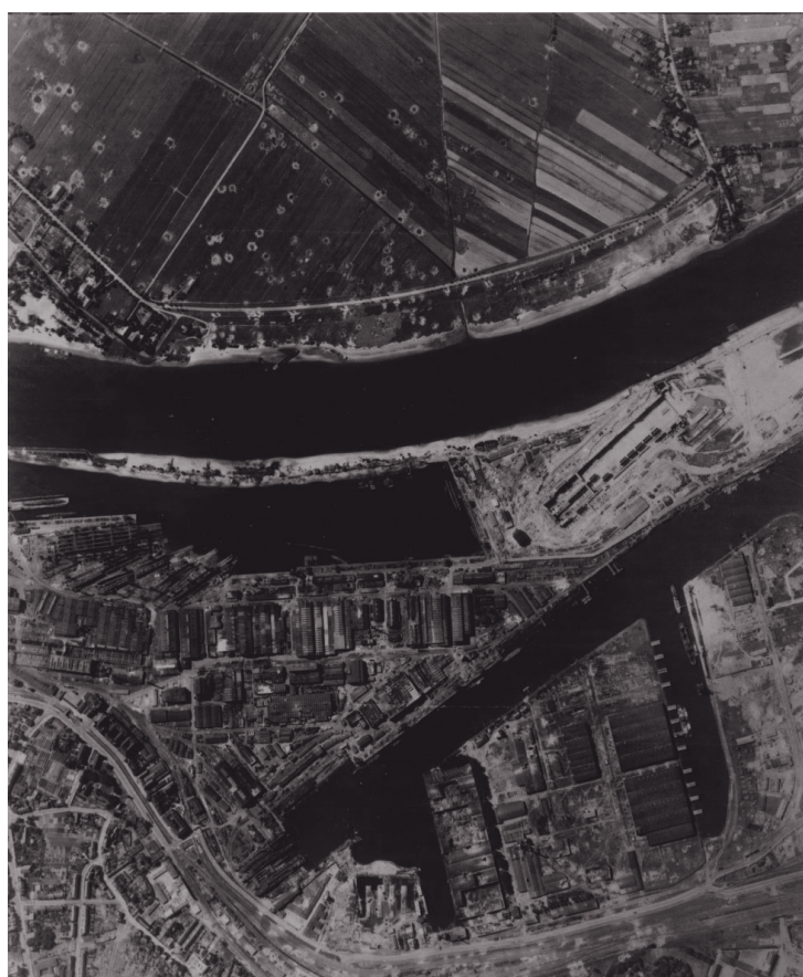
Luftaufnahme aus einem alliierten Flugzeug vom 19.8.1944. Auf der Halbinsel erkennt man den im Bau befindlichen U-Bootbunker, noch ohne Wasserverbindung zur Weser.
