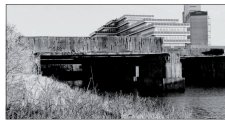
Der Bunker wurde nie fertig gestellt. Die gewaltigen Betonmauern dienten 1968 als Fundament für das Verwaltungsgebäude einer Speditionsfirma.
