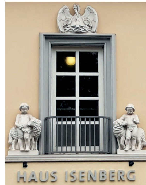
Bauplastiken über dem Haupteingang symbolisieren aufopfernde Hilfe. (7)
